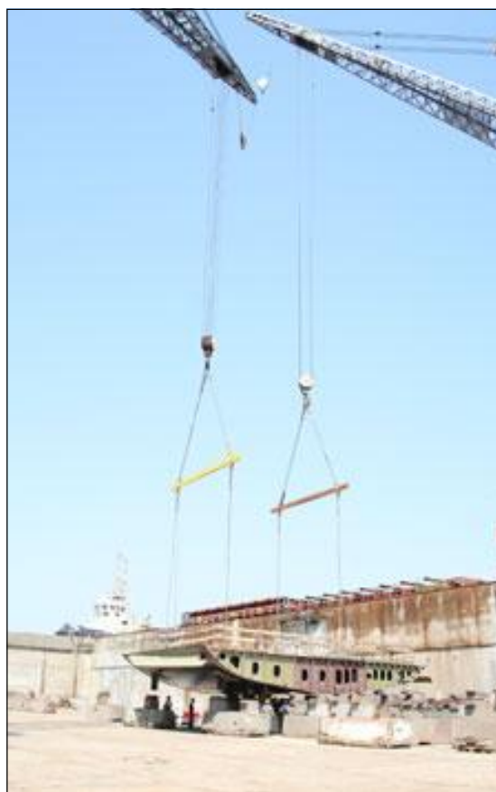
Den første sektion hejses på plads i byggedokken.
