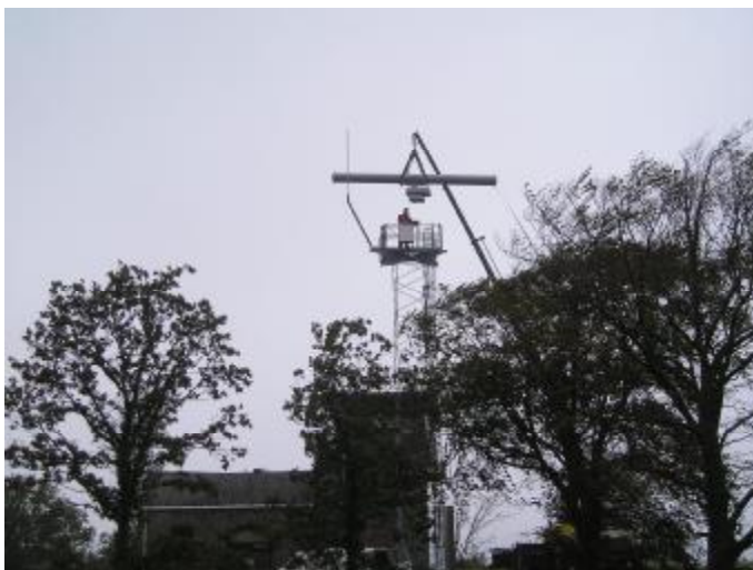
Antennen på Hammeren sættes op.
